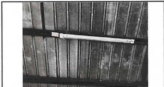
Foto 3: Sustitución de lámparas LED.
